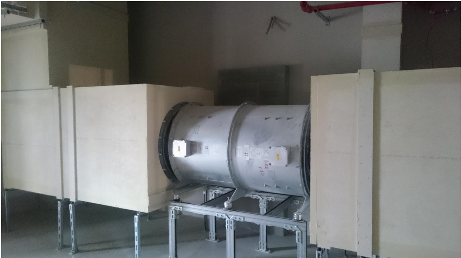
Dvostupanjski aksijalni ventilator sustava za odimljavanje, HT 400°C, 120 minuta
